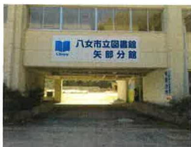
新矢部分館（旧矢部小学校）
