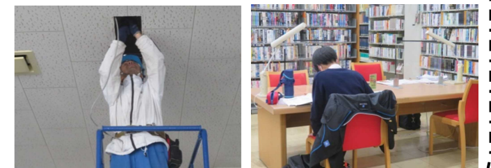
照明器具の交換
